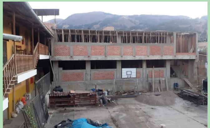
Aktueller Baufortschritt an der Schule
